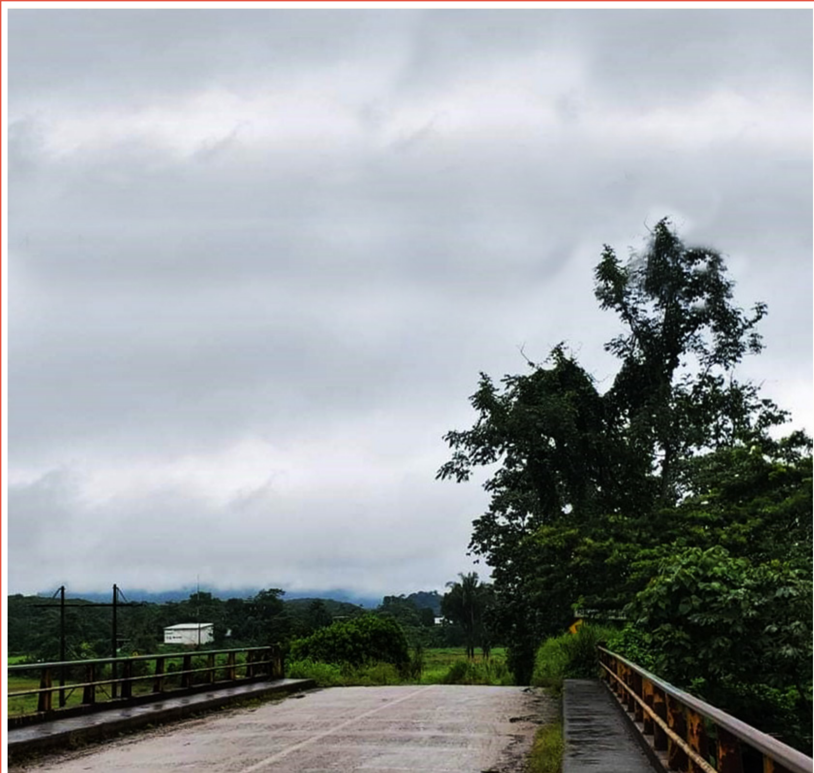
Puente divisorio de los Poblados 11 y 12
