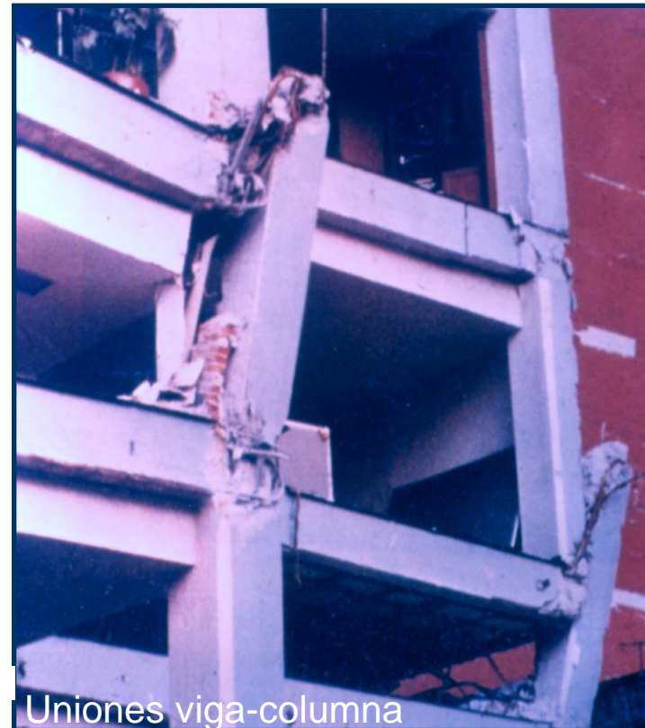
Cortante en columnas
