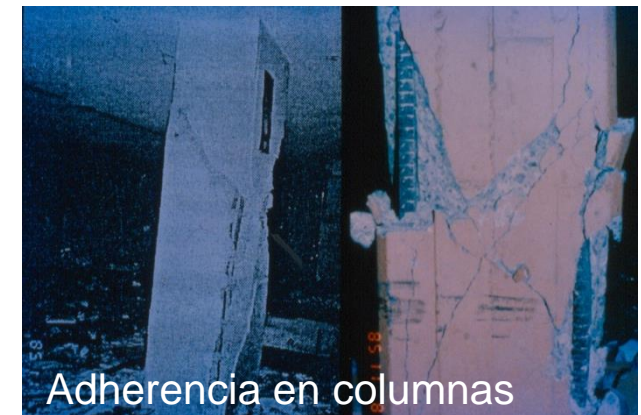
Cortante en columnas
