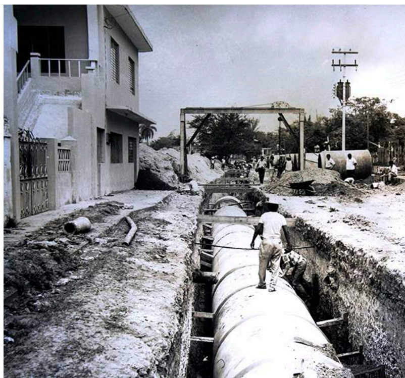
Colocación de tubería para drenaje, 1969, Tampico, Tamaulipas. CONAGUA-AHA, Fondo Colección Fotográfica, Caja 76, Expediente 1928.
