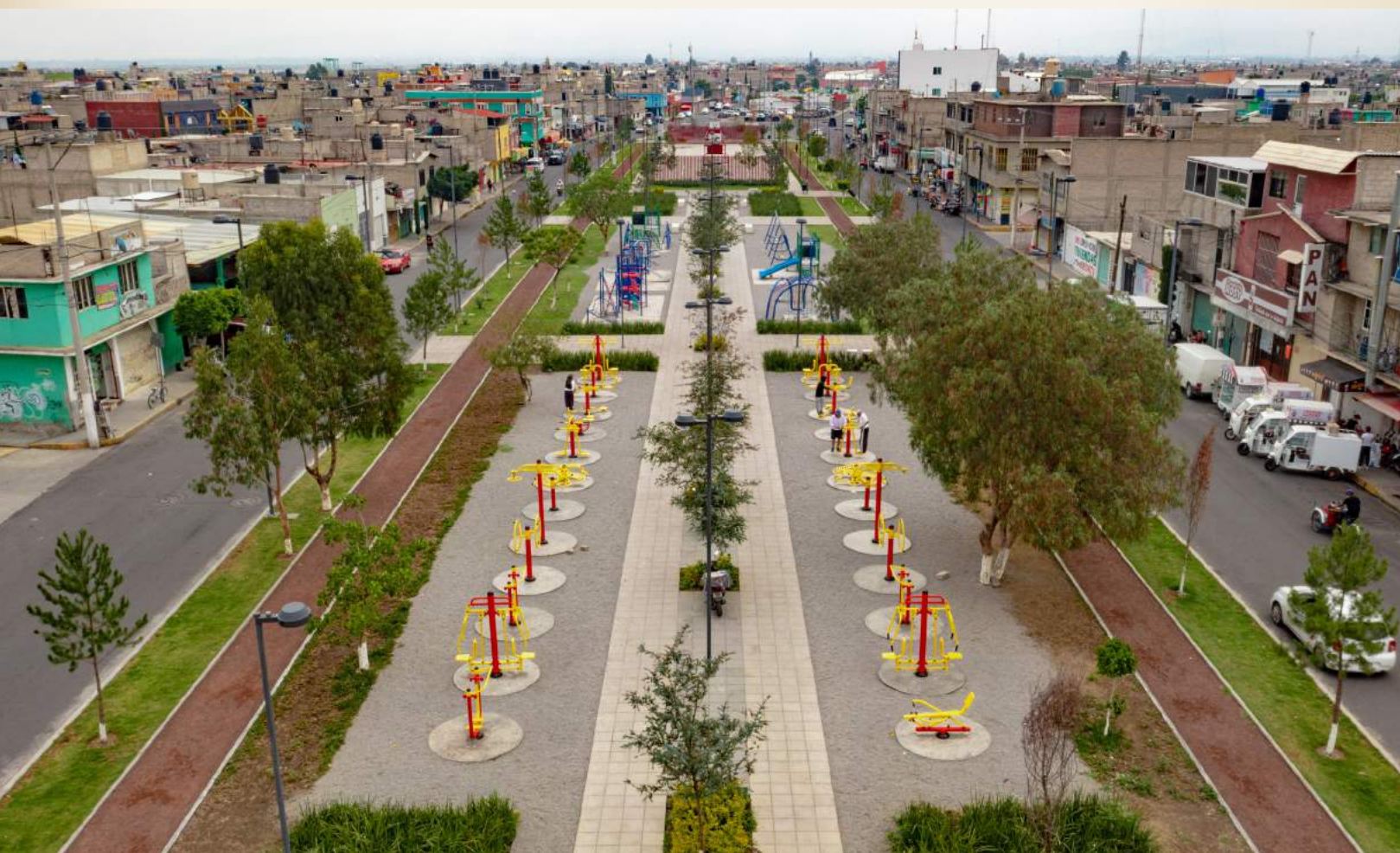
Fotografía 2. Construcción de centro de desarrollo comunitario y parque lineal amayalco, Chimalhuacán, Estado de México.
