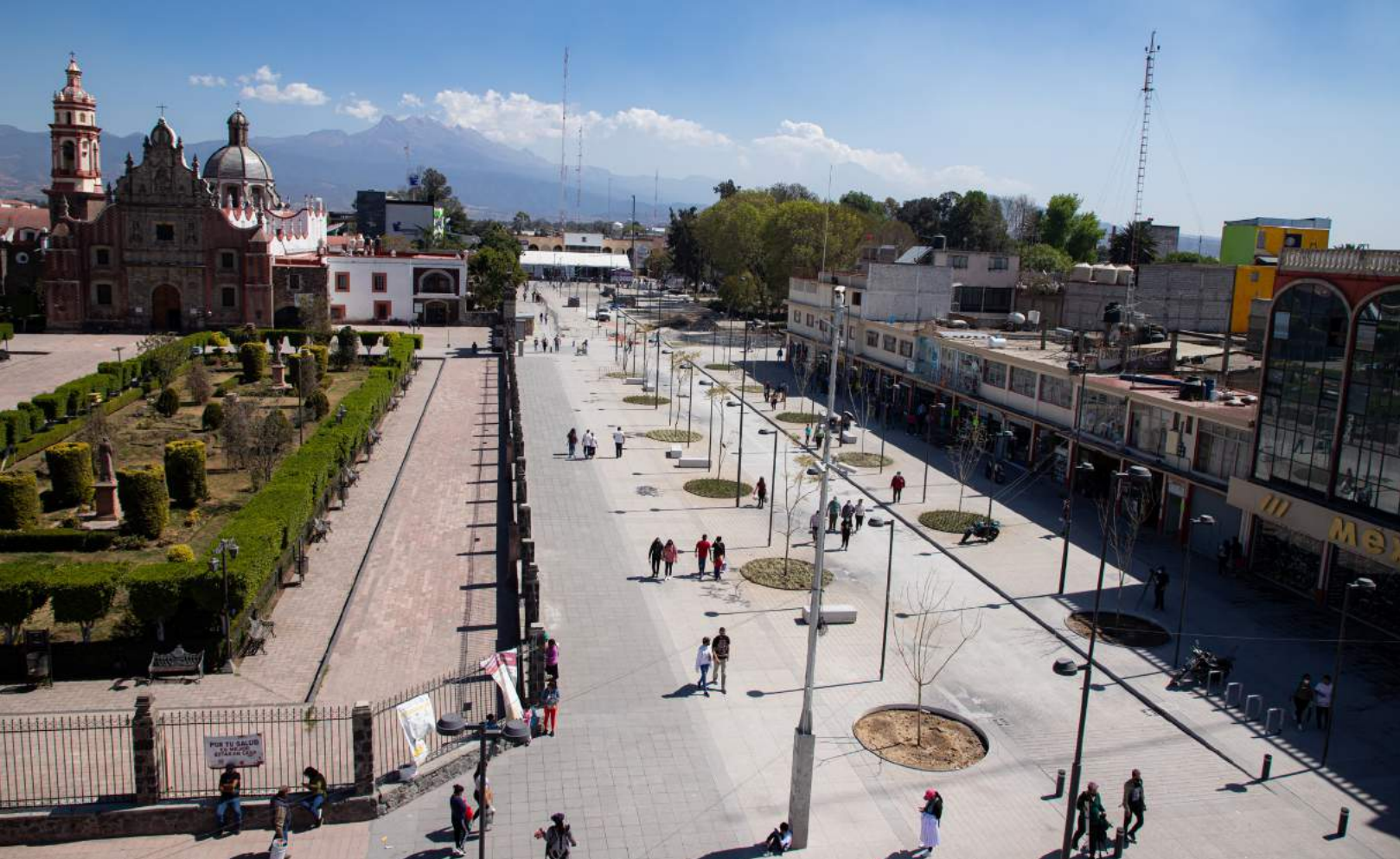
Fotografía 1. Construcción de calles en el Centro Histórico Porfirio Díaz, Chalco Estado de México.
