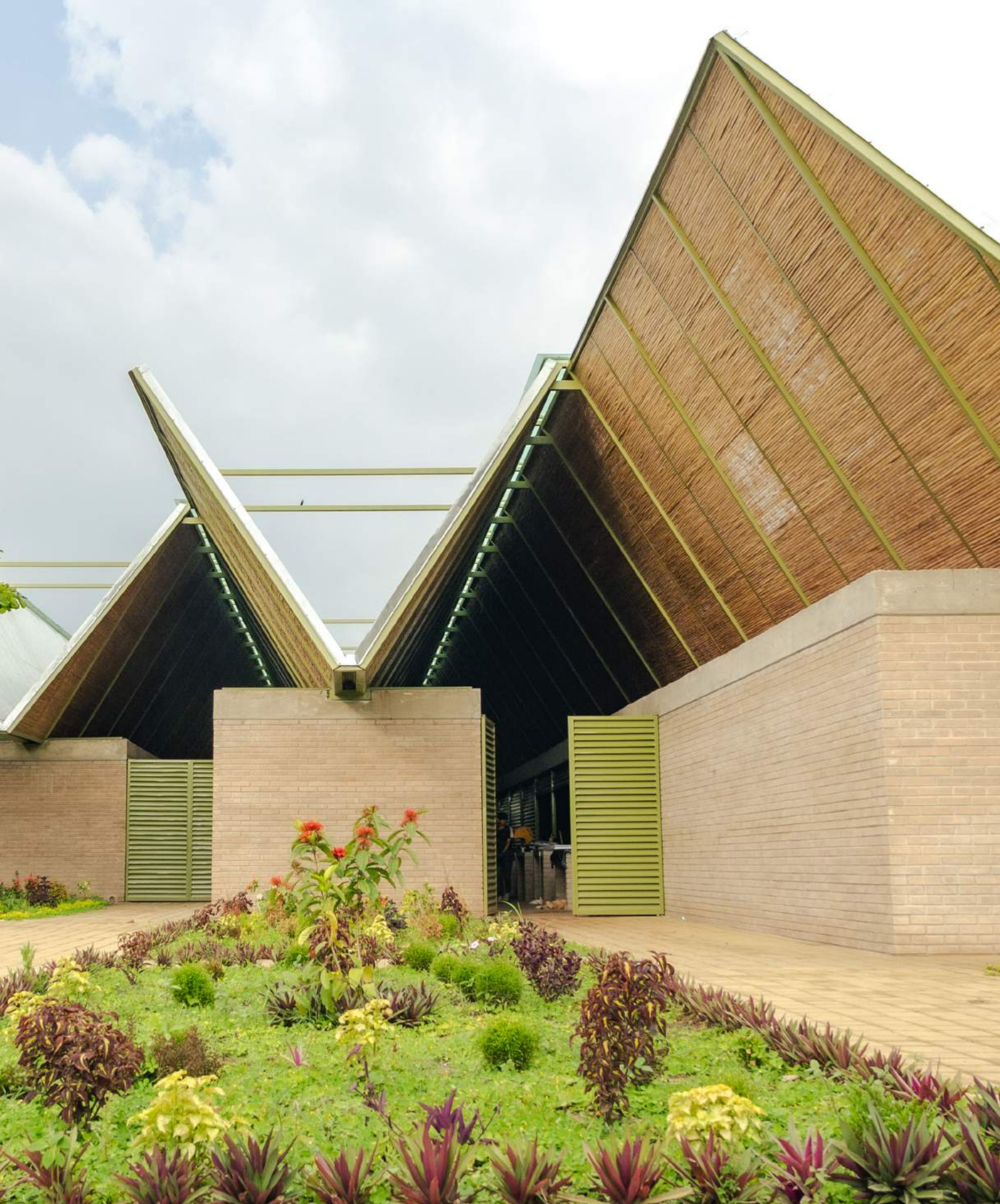
Fotografía 3. Construcción del Mercado Guadalupe en la colonia Indeco, Tapachula, Chiapas.
