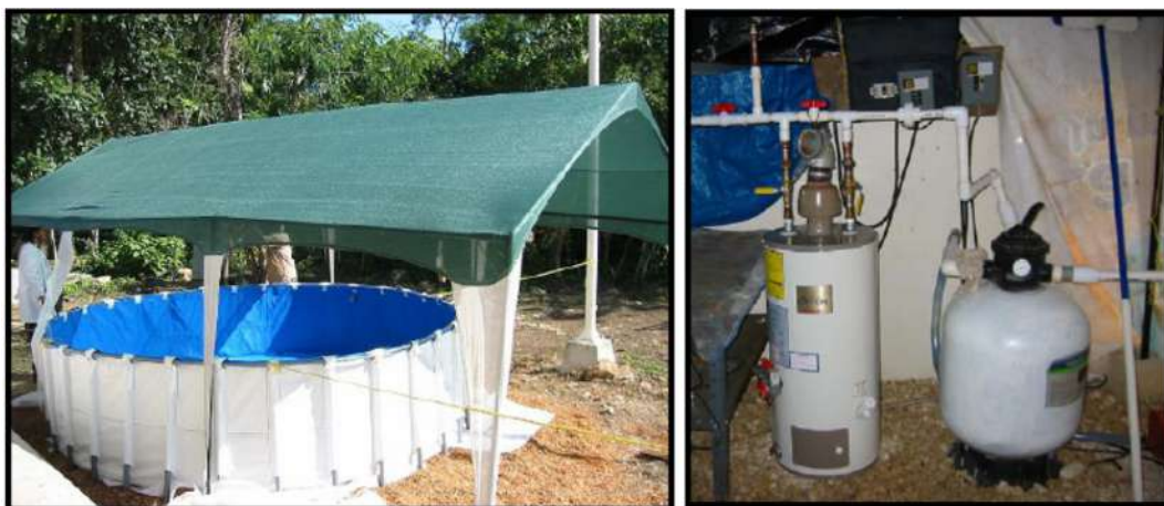
Figura 4. Alberca y sistema de purificación y control de temperatura de agua, para el mantenimiento de la cría "Daniel" [18]. Fotografías Janneth Padilla.
