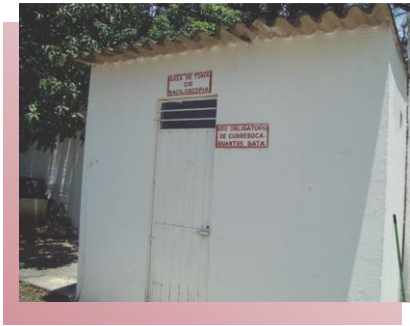
Foto 1. Implementación de espacios no adecuados para la detección.
