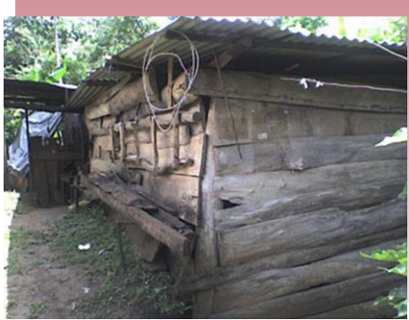
Foto 14. Domicilio de afectado por tuberculosis.
