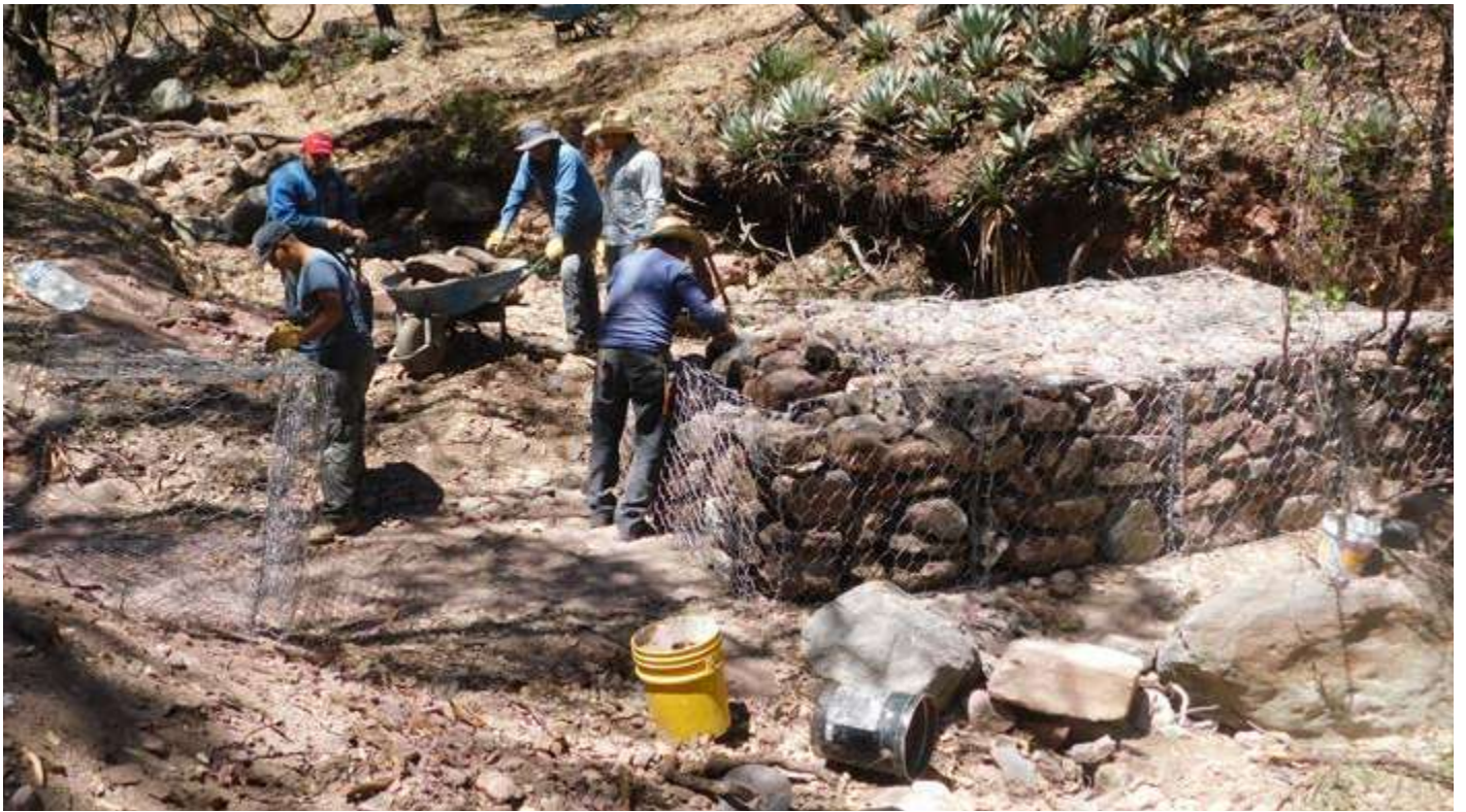
Construcción de Gaviones en el PN Cumbres de Majalca.
