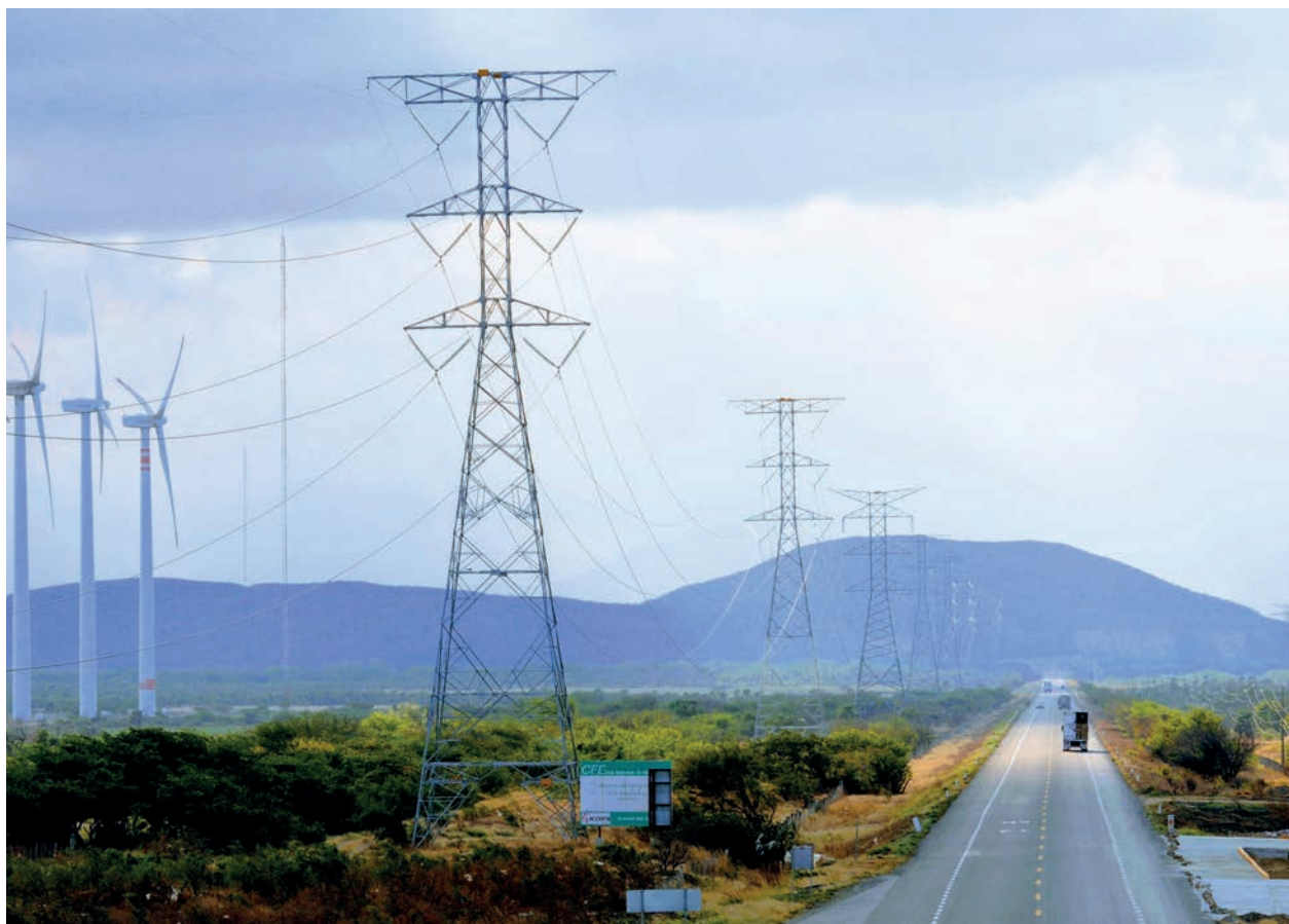
Fotografía 13. Torre de transmisión, Campo eólico. Oaxaca. CFE.
