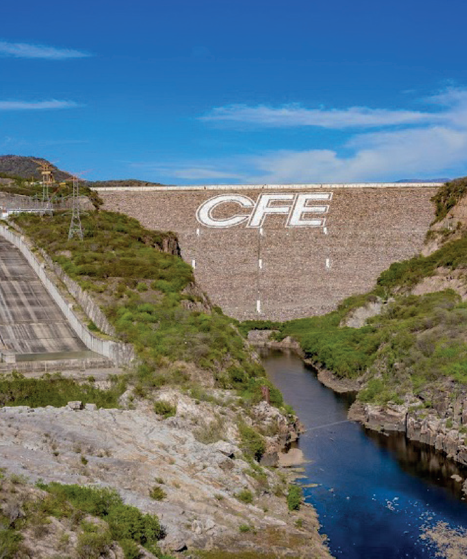
Fotografía 38. Presa, "Leonardo Rodríguez Alcaine". Río Grande Santiago, Santa María del Oro, Nayarit. 2019. CFE.
