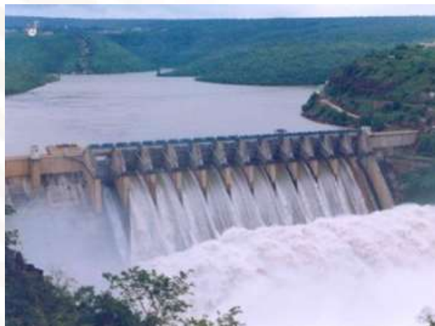
Construcción de presas
