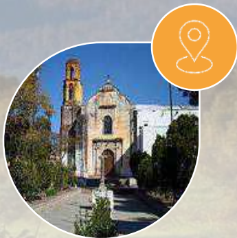
RFI: 17-4189-6 Y 17-1669-7 Templo y Antiguo Convento de Santiago Apóstol, Ocuituco, Morelos.
