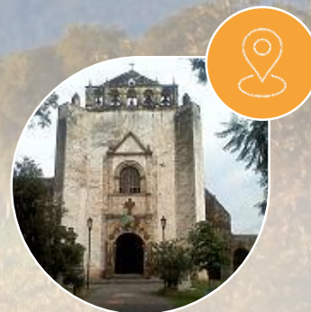
RFI: 17-3997-8 Convento de San Juan Bautista, Tlayacapan, Morelos.
