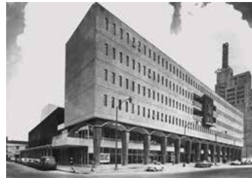
CENTRO DE SEGURIDAD SOCIAL HIDALGO EN LA CIUDAD DE MÉXICO.
