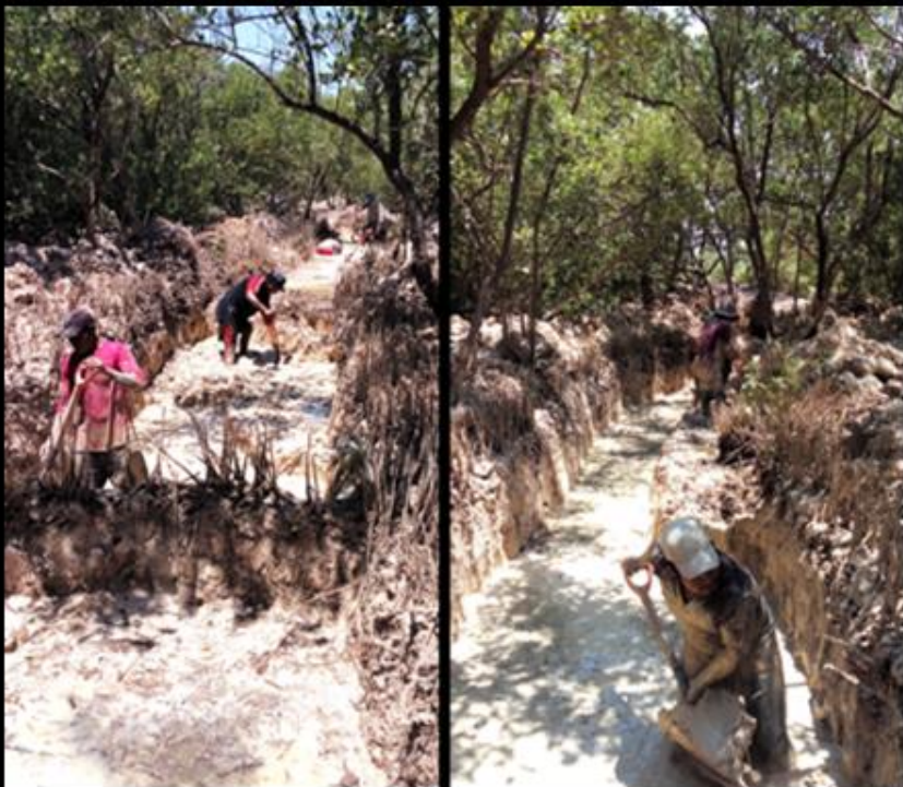
Excavación de canales artificiales en el año 2018
