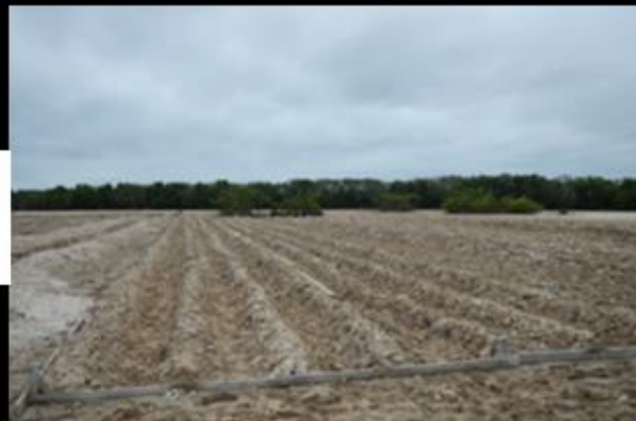
Construcción de Plataformas artificiales
