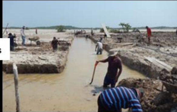
Excavación de canales artificiales
