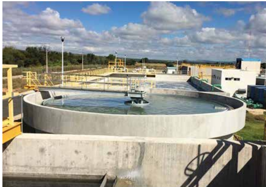
Sedimentador secundario
