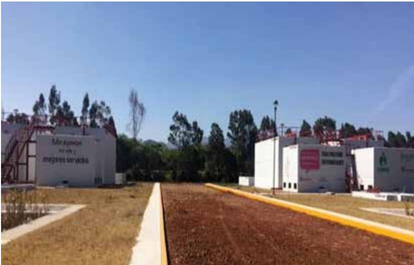
Vista general de la planta
