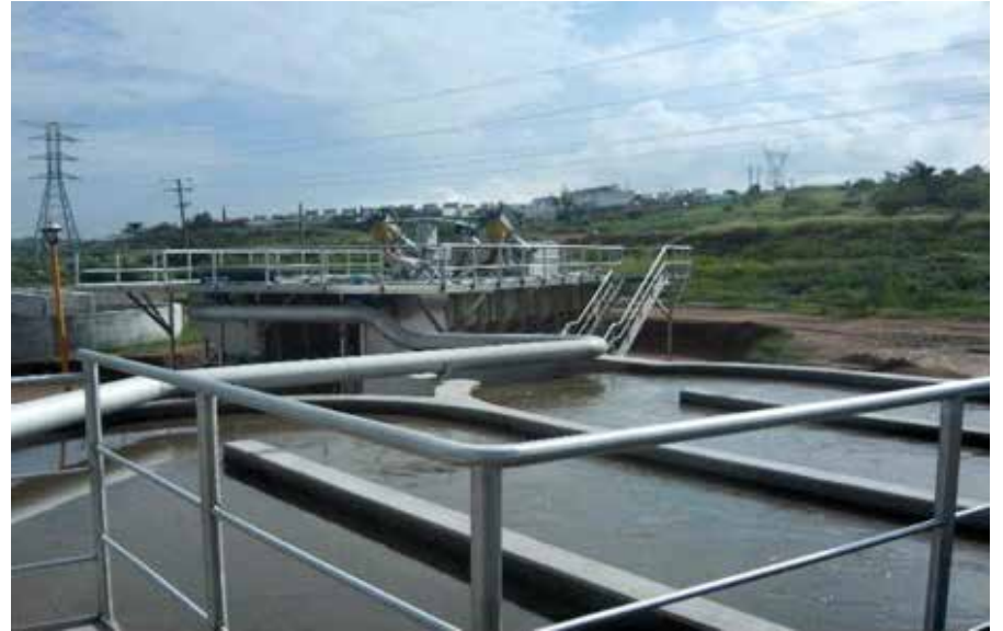
Zanja de oxidación
