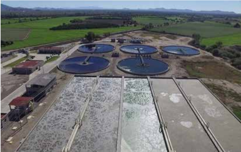
Vista aérea del sistema de lodos activados
