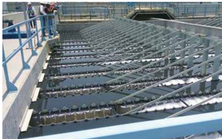
Sedimentador secundario
