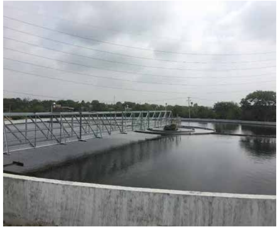
Sedimentador secundario
