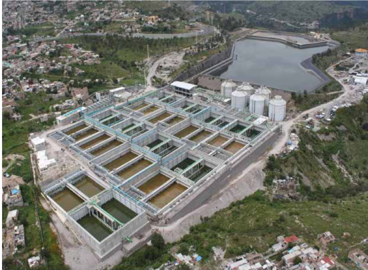
Vista aérea de la planta
