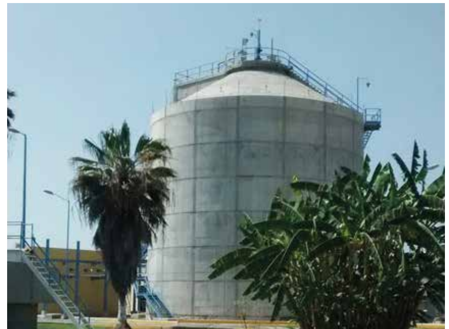
Digestor anaerobio de lodos
