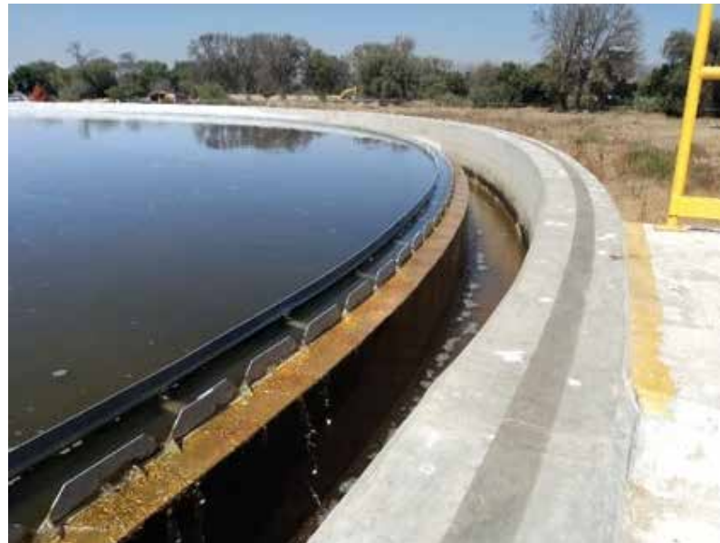
Sedimentador secundario
