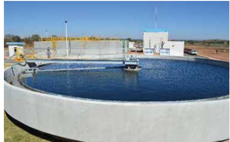
Sedimentador secundario
