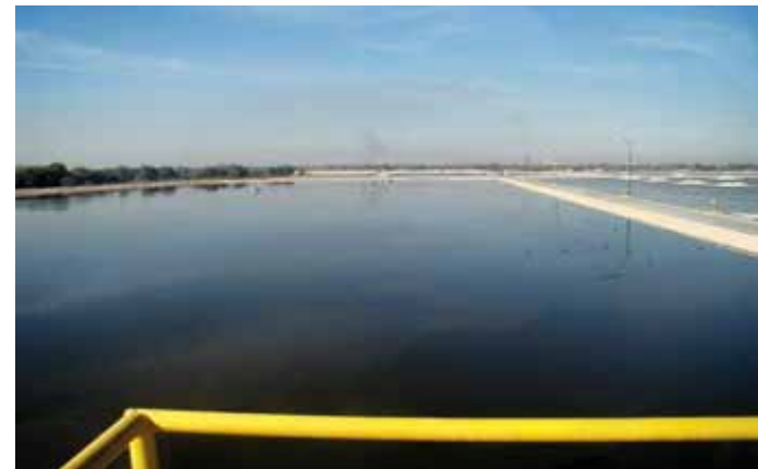
Laguna de Maduración
