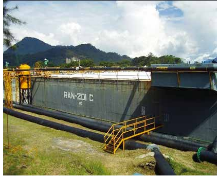
Reactor Anaerobio de Flujo Ascendente
