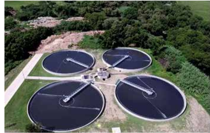
Sedimentador secundario
