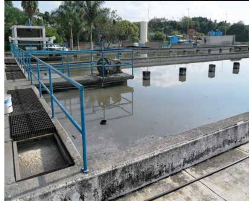
Sedimentador secundario
