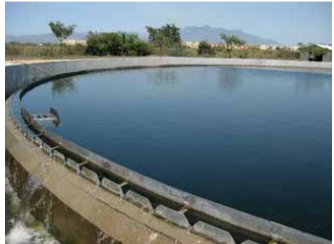
Sedimentador secundario
