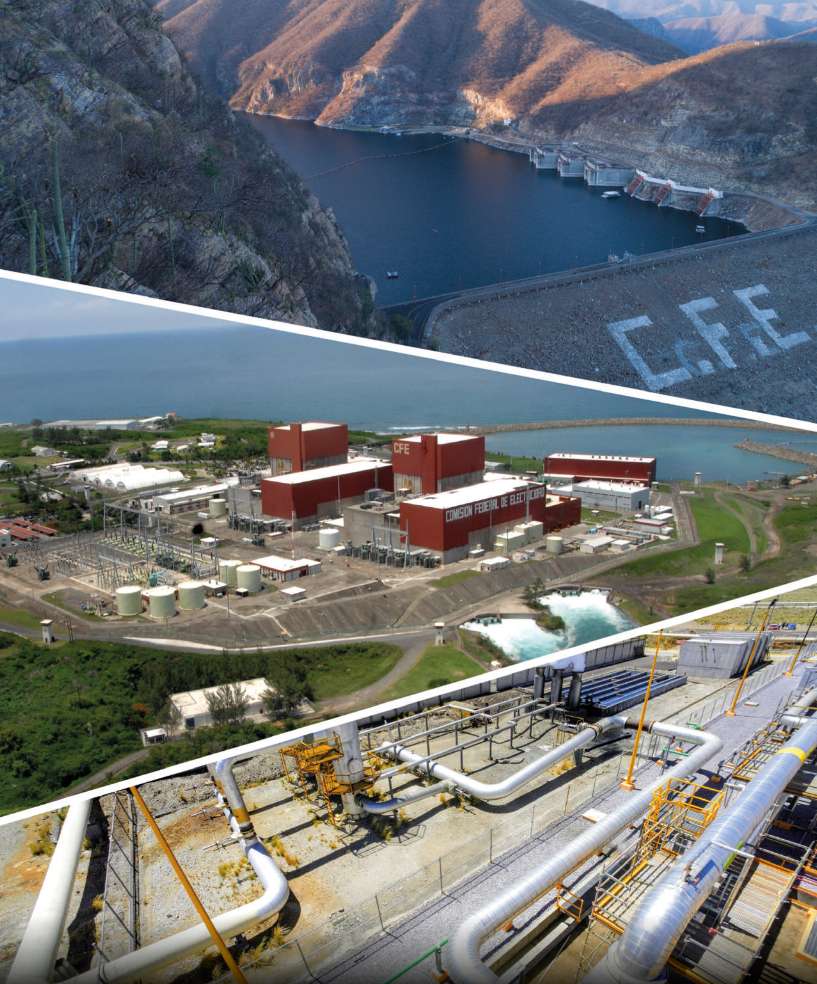
Fotografía 6. Central Nucleoeléctrica "Laguna Verde", Alto Lucero, Veracruz. Central Hidroeléctrica "Aguamilpa Solidaridad". Río Grande De Santiago, Nayarit. Central Geotérmica "Los Humeros", Puebla. | Comisión Federal de Electricidad.
