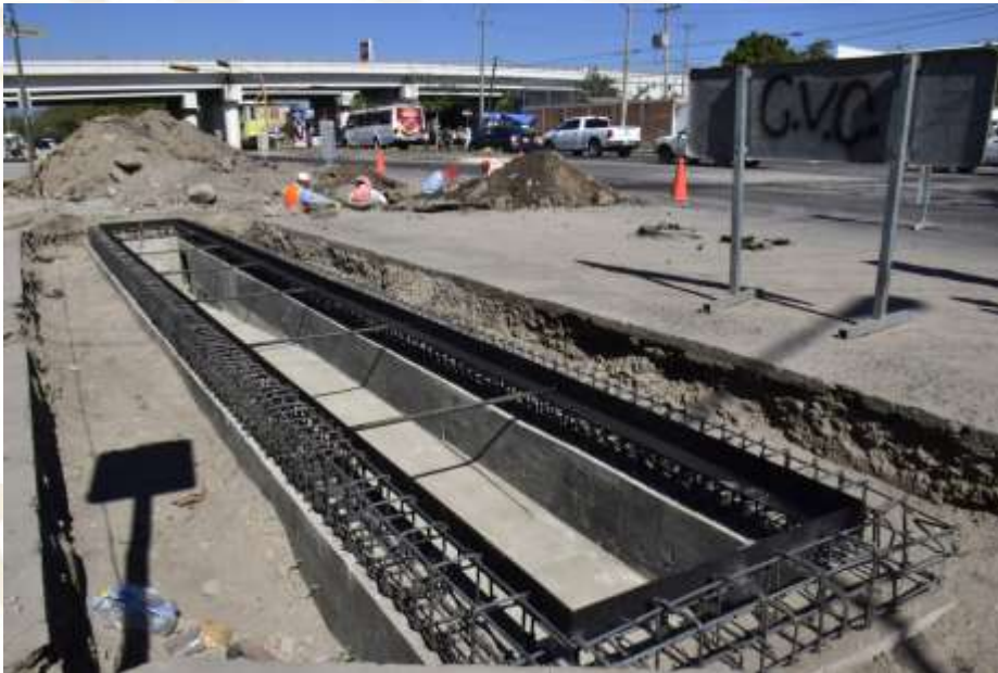
Construcción boca de tormenta, Ciudad de Colima
