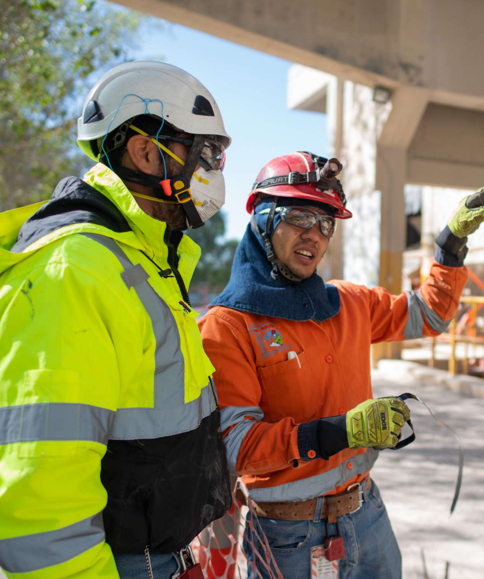
Fotografía 7. Trabajadores del sector de la construcción portando el equipo indispensable para desempeñar sus actividades. Año 2020.
