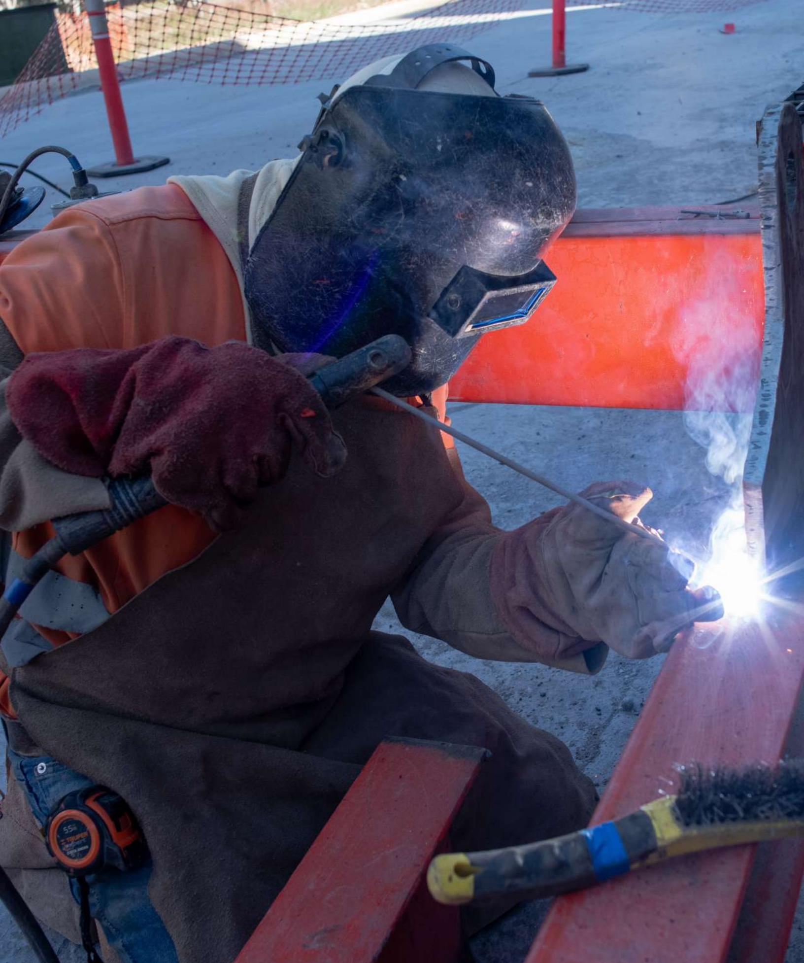
Fotografía 1. Aprendiz del Programa Jóvenes Construyendo el Futuro, realizando su capacitación con el equipo necesario. Año 2020.
