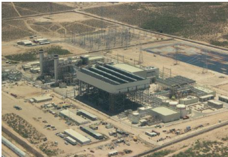
Figura 2.43. Estación de ciclo combinado Agua Prieta II. Fuente: (SENER, 2016)
