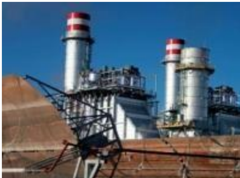
Figura 2.46. Central eléctrica Ain Beni Mathar. Fuente: (ABENGOA, 2019)
