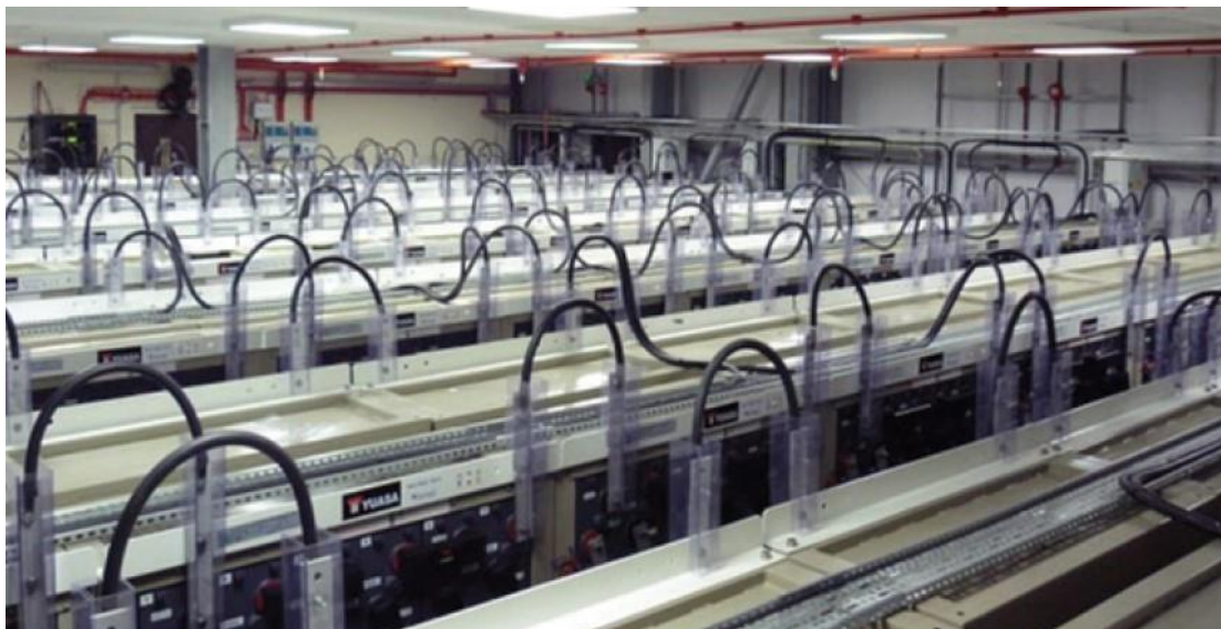
Figura 2.25. Cuarto de baterías en la Central Eléctrica Lerwick. Fuente: (GS Battery Inc., 2016)
