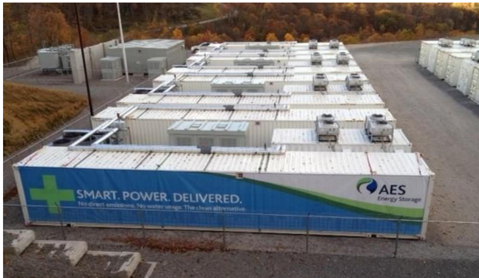
Figura 2.17. Sistema de LIB de la central eólica de Laurel Mountain. Fuente: (AES)
