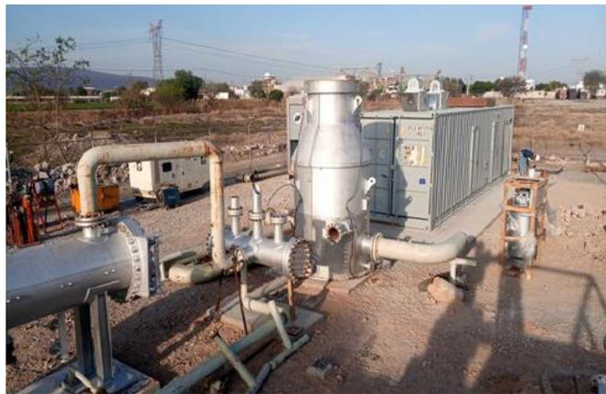
Instalación y pruebas con vapor geotérmico en condiciones reales de campo de la unidad BPU 500 kW, del proyecto Mecanismo de Fondo revolvente para el Financiamiento
