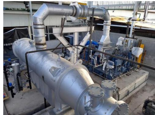
Turbina de VSC multicapa hasta de 1000 kW del Proyecto de Cogeneración de energía para autoabastecimiento, utilizando biomasa forestal como combustible
