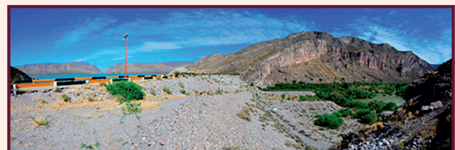
Presa Francisco Zarco-Las Tórtolas
