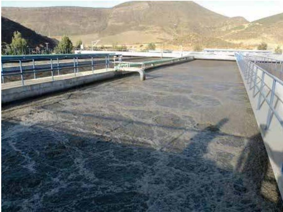
**Zanjas de oxidación**
