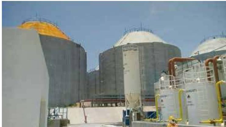
**Digestor anaerobio de lodos**
