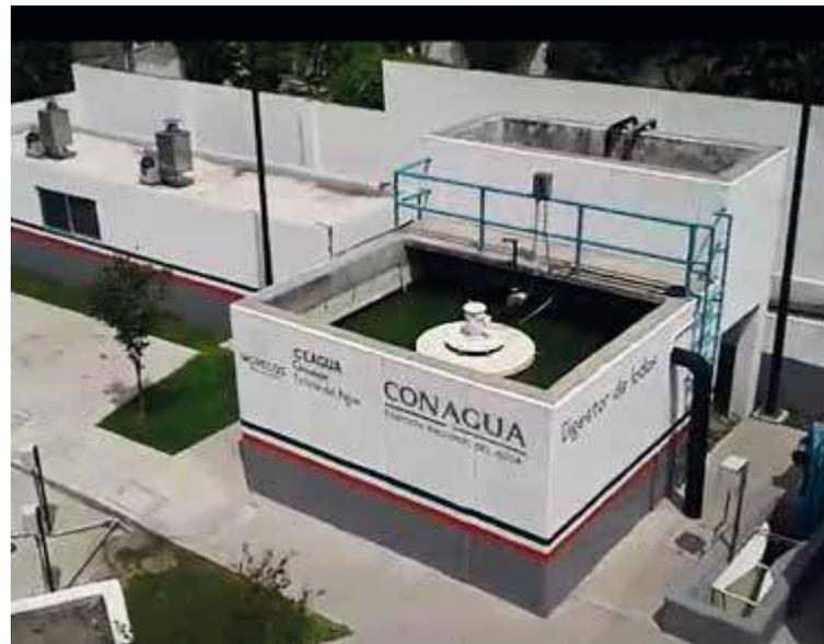
**Digestor aerobio de lodos**
