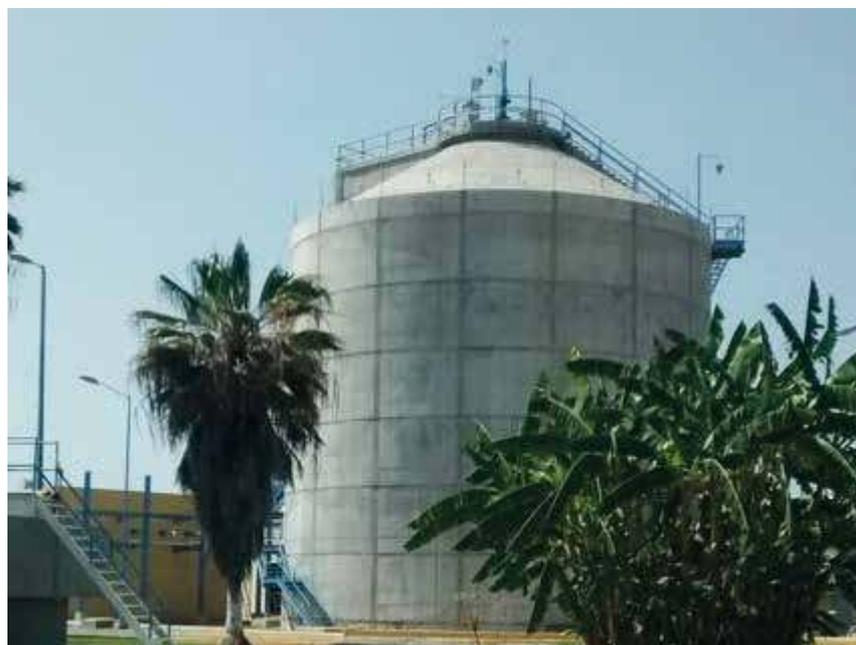
**Digestor anaerobio de lodos**
