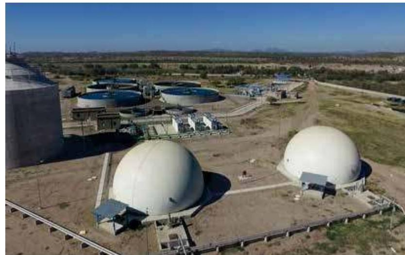
**Almacenamiento de biogas y equipos de cogeneración**
