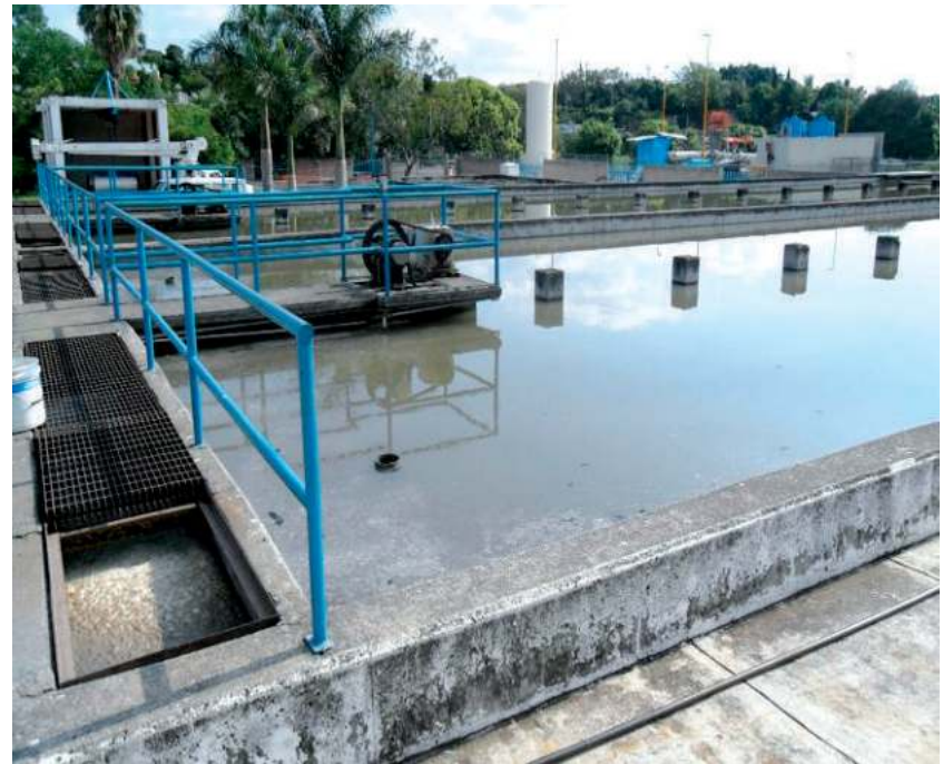
Sedimentador secundario
