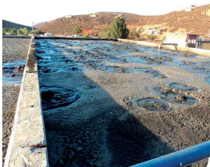
Zanjas de oxidación
