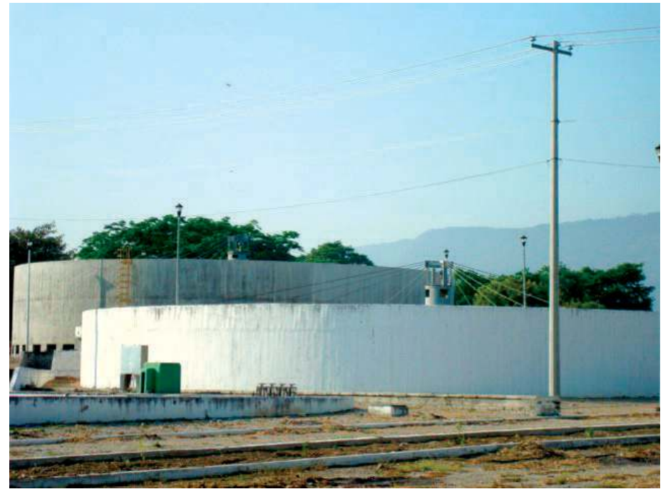
Filtro biológico (percolador) y al fondo, sedimentador secundario
