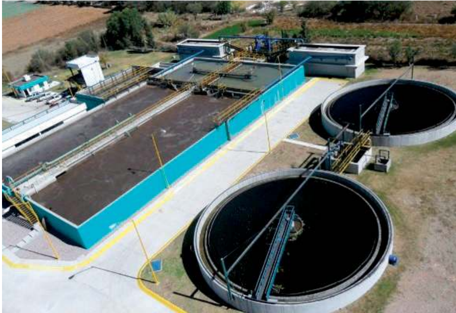
Reactor aerobio y sedimentador secundario
