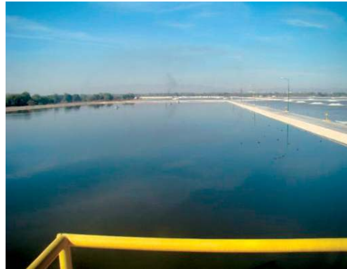
Laguna de maduración
