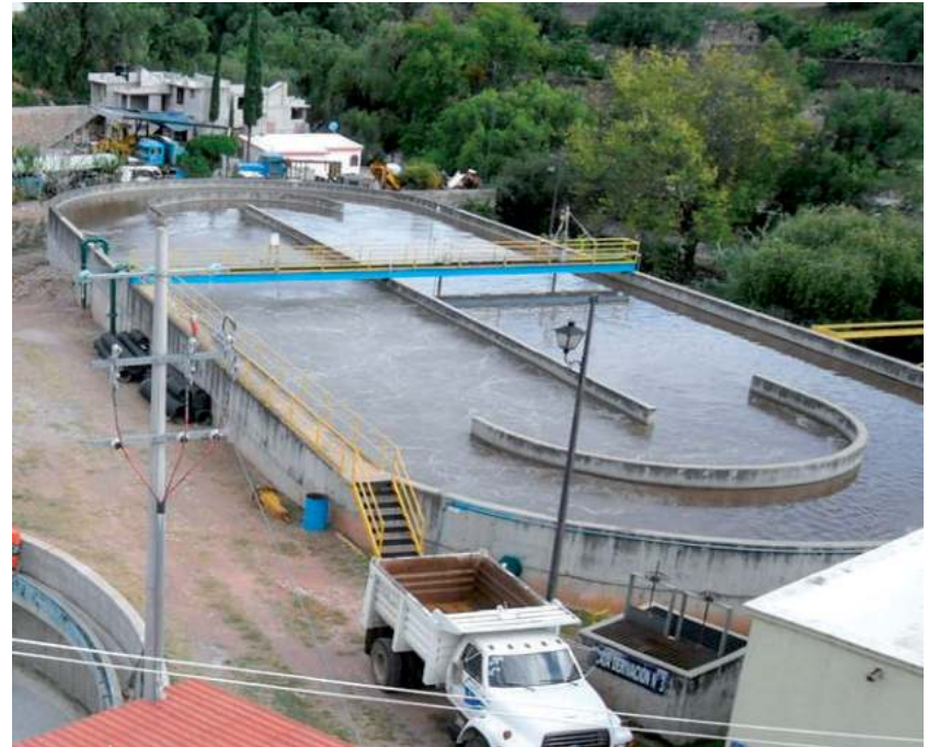
Zanjas de oxidación
