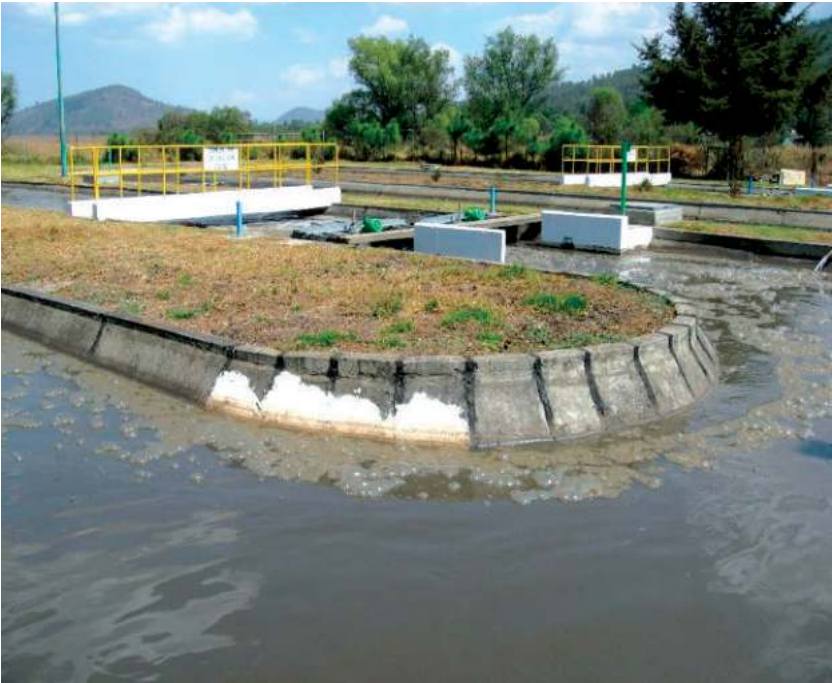
Zanjas de oxidación
