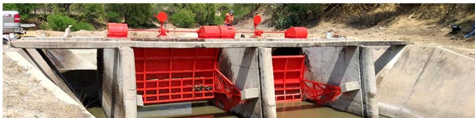
infraestructura hidráulica consta de una barrera de concreto y un sistema de compuertas radiales para embalsar el agua en su cauce, y posteriormente poder enviarla a riego en bloques a través de tomas laterales”, explicó Armando Hernández Mendoza, director local de la CONAGUA en Hidalgo.
