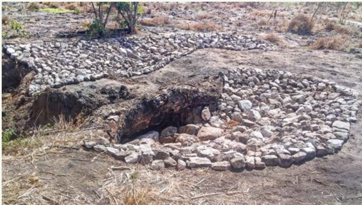
FIGURA 10. Cabeceo de cárcavas en el sitio de restauración.
