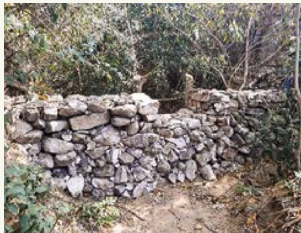
FIGURA 12. Presas filtrantes de piedra acomodada.
