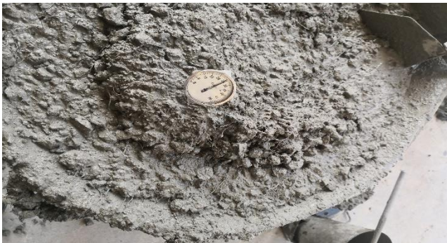
Ilustración 3. Toma de temperatura al concreto fresco.
