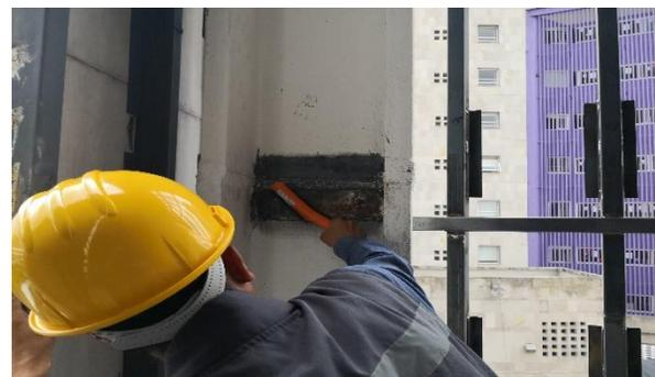
Ilustración 2. Limpieza del área a inspeccionar.
