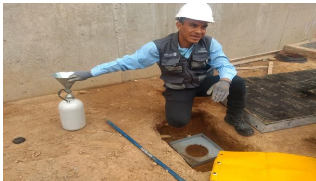
Ilustración 7. Uso del método de cono y arena en rampa de acceso.
