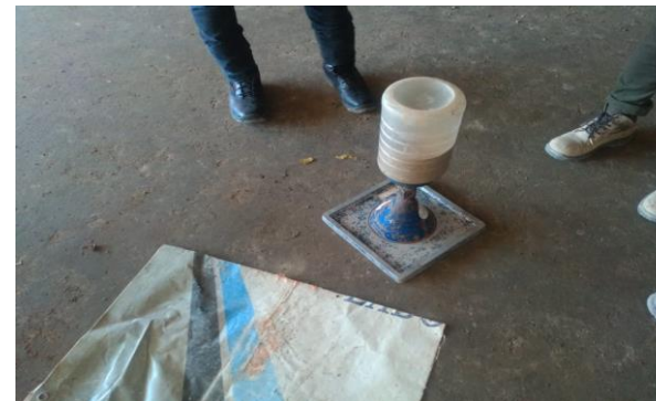
Ilustración 6. Verificación del grado de compactación en base.
