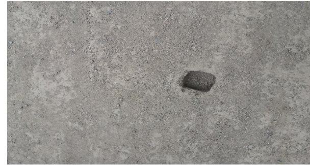
Ilustración 4. Sondeo realizado en el estacionamiento del personal.
