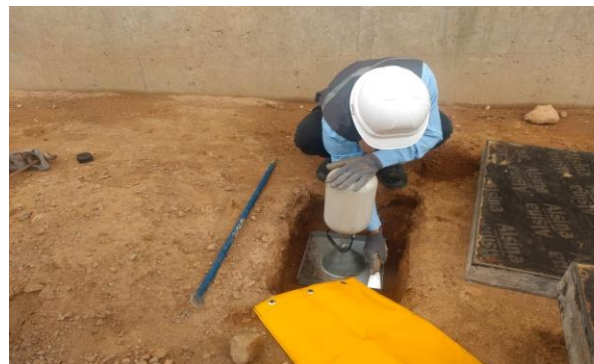
Ilustración 8. Verificación del grado de compactación en terraplén.
