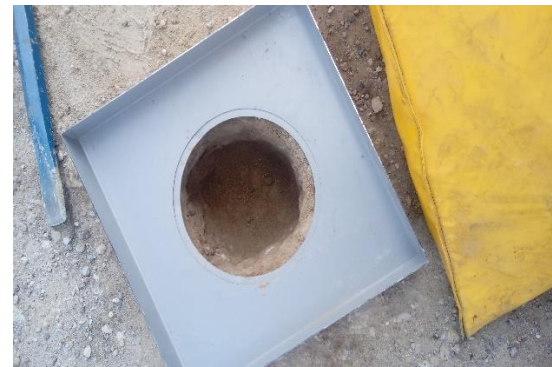
Ilustración 4 Excavación denominada como sondeo.
