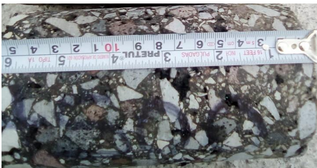
Ilustración 3. Medición del espesor de la carpeta asfáltica.
