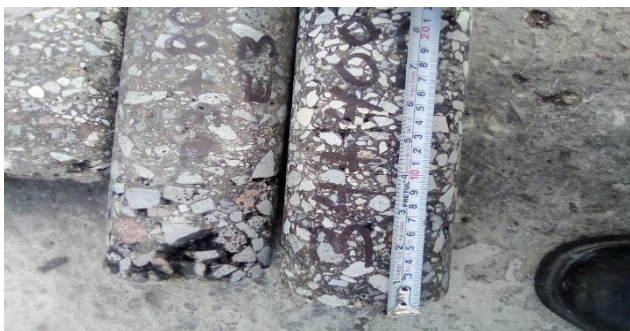
Ilustración 3. Medición del espesor de la carpeta asfáltica.
