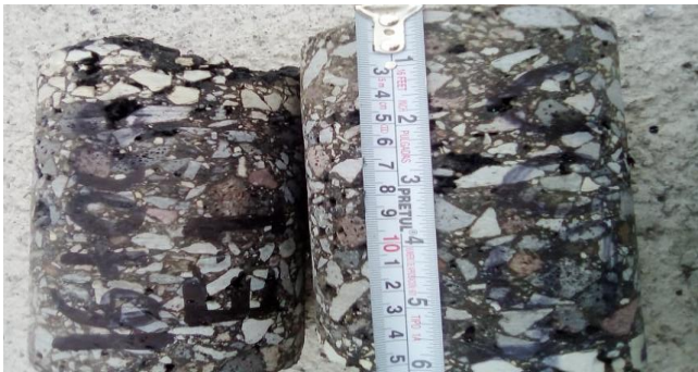
Ilustración 3. Medición del espesor de la carpeta asfáltica.
