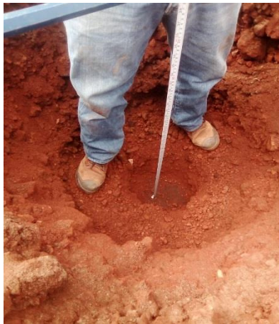
Ilustración 7. Nivel de geotextil.
