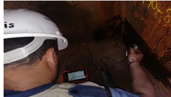
Ilustración 15. Inspección en primera y segunda pierna
