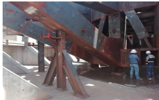
Ilustración 16. Evaluación de la soldadura
