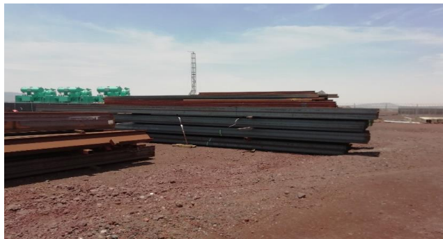
Ilustración 19. Cúmulo de elementos sin primer en Zona 3
