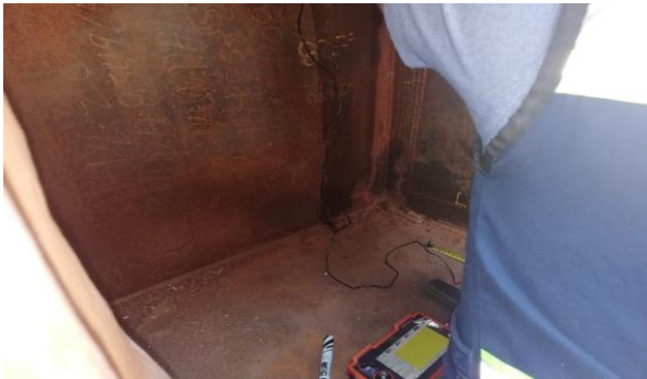
Ilustración 14. Barrido de la soldadura
