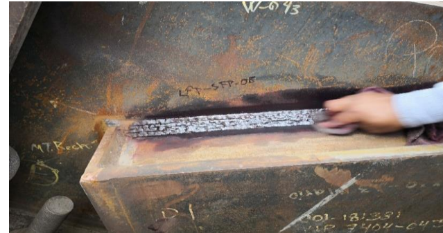
Ilustración 4. Limpieza del cordón de soldadura
