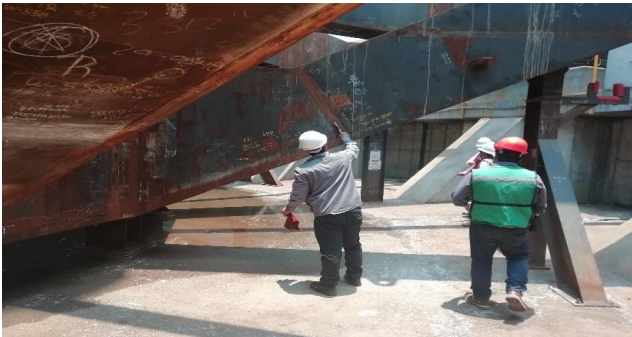
Ilustración 3. Retiro de agentes externos a la soldadura
