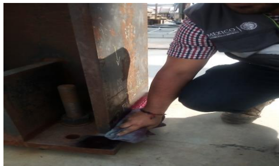
Ilustración 7. Retiro del exceso del líquido penetrante
