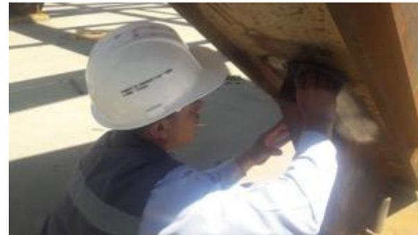
*Ilustración 4 Limpieza del cordón de soldadura*
