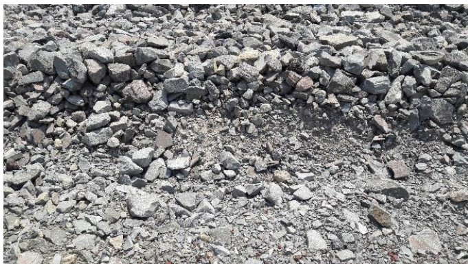
Ilustración 7. Agregado fino que abunda en las capas del material denominado precarga.
