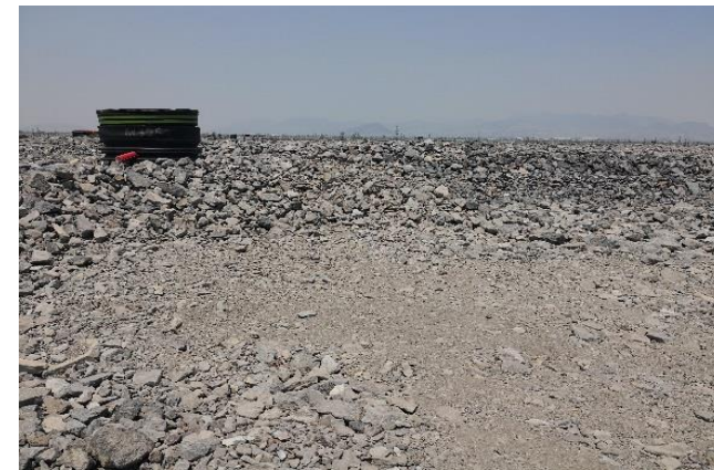
Ilustración 6. Cuadrante donde se visualiza que en la capa inferior predomina material de agregado fino.
