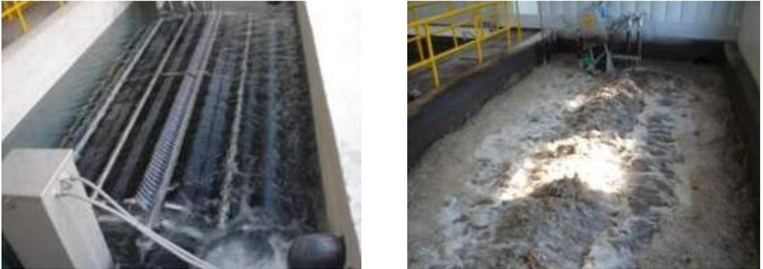
Figura 3.6. Membrana de ultrafiltración: funciona para separar el lodo activado del agua tratada removiendo sólidos de hasta 2  $\mu\text{m}$ . Fotos proporcionadas por transparencia UNAM.
