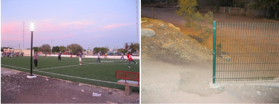
Empastado artificial, luminarias, bancas y enrejado parcial Unidad Deportiva Satélite.
