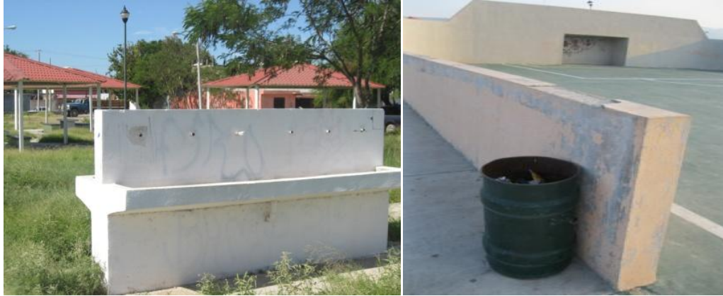
Ausencia de llaves en bebederos, cestos de basura insuficientes en los parques Ampliación López Mateos y La Moderna.
