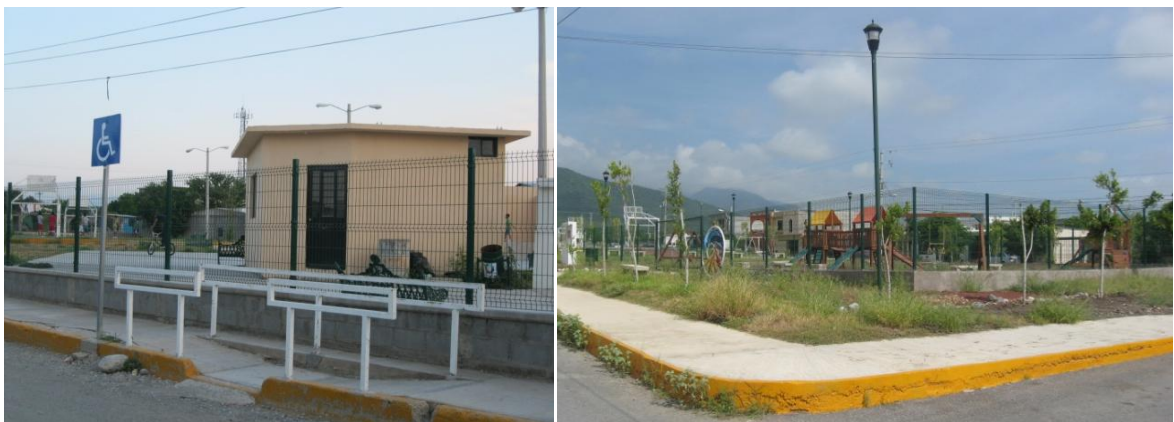
Reja de acero perimetral en Parque La Moderna y en el área de juegos infantiles de Colinas del Valle.
