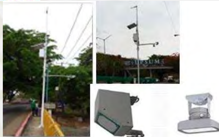
Sensores (lluvia, ríos)
