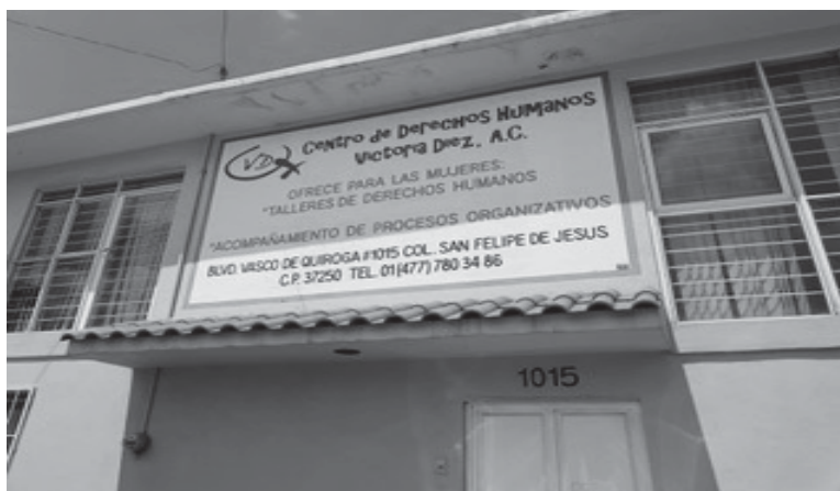
Imagen 4.15. Fachada del Centro de Derechos Humanos Victoria Díez
