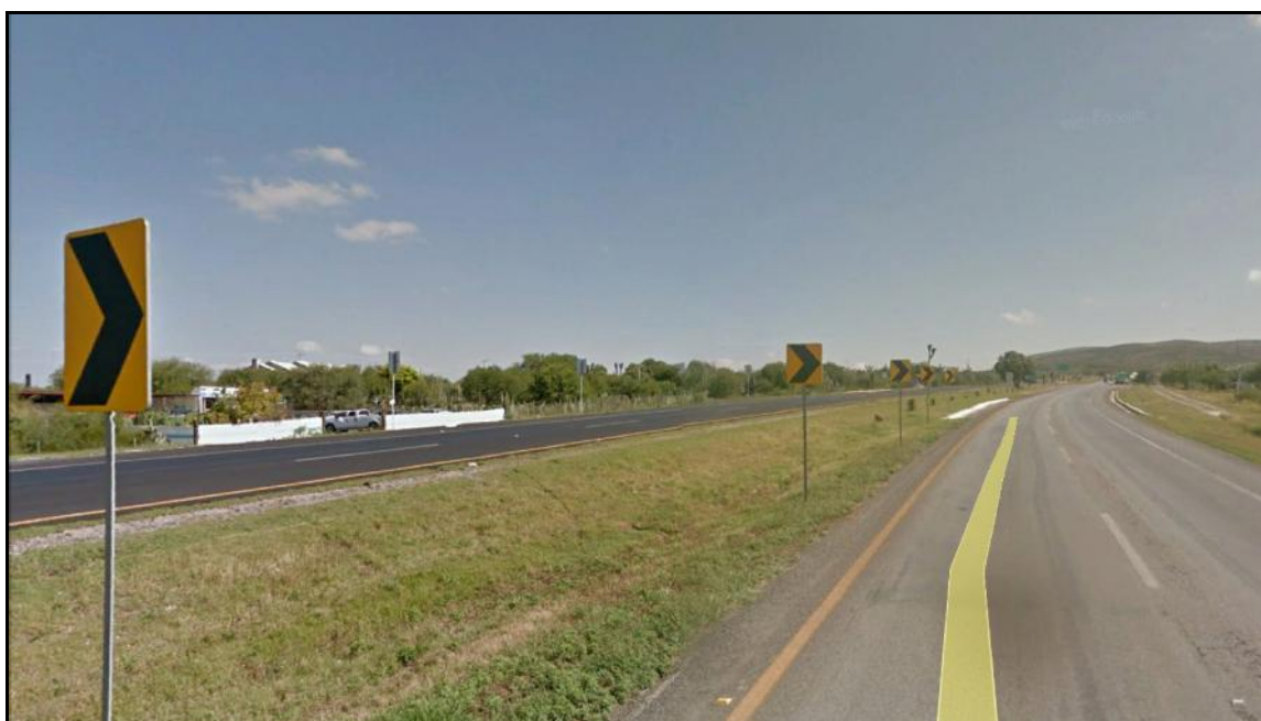
Fotografía Google de la carretera México 57 en su punto inicial Km. 24+640. Nótese que tiene 2 cuerpos.
