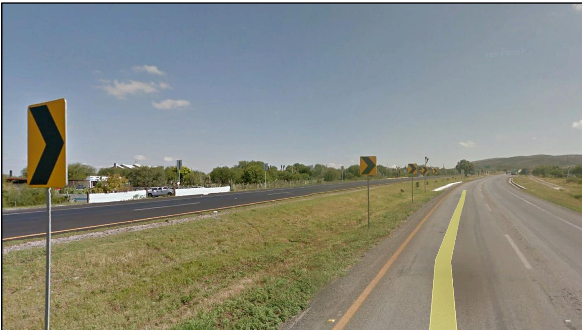
Fotografía Google de la carretera México 57 en su punto inicial Km. 24+640. Nótese que tiene 2 cuerpos.
