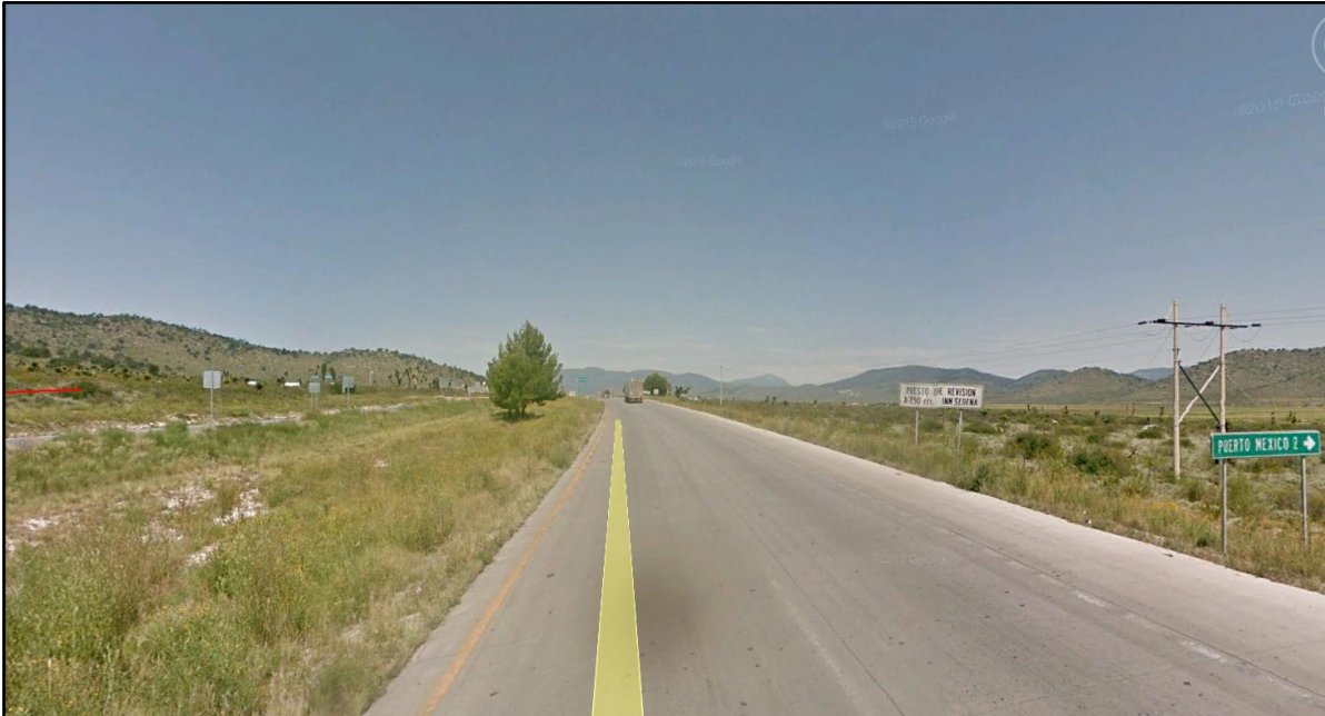
Fotografía Google de la carretera México 57 en su punto inicial Km. 202+100. Nótese que tiene 2 cuerpos.
