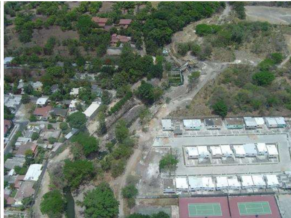
Construcciones en zona federal
