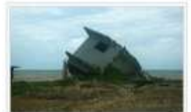
Casa destruida en Kingston, Jamaica tras el paso del Huracán Dean. 67
