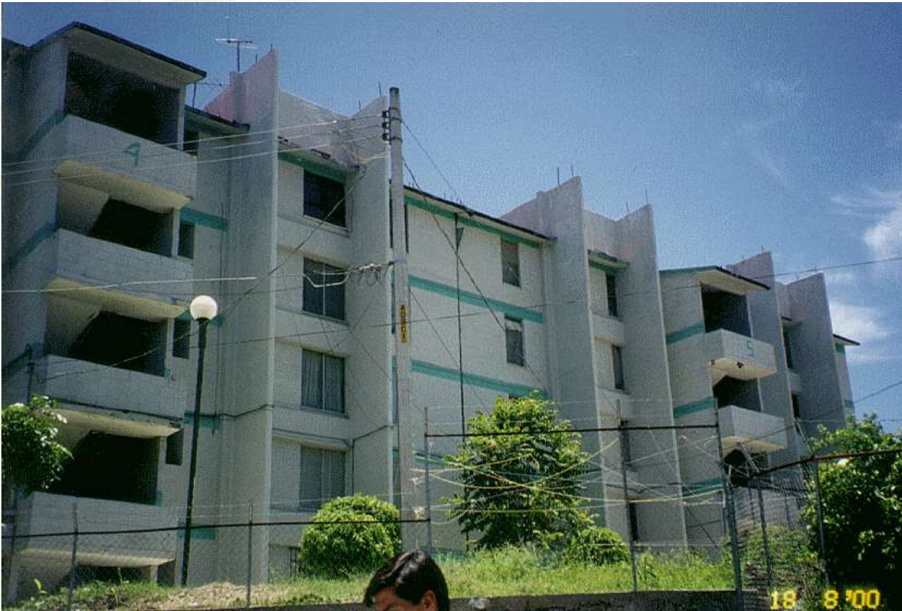
Muros de concreto (contrafuertes)
