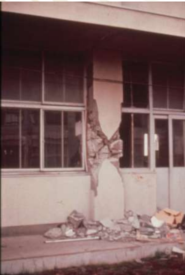
Acortamiento de columnas
