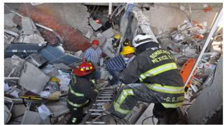
Bomberos de México realizan labores de rescate de víctimas y de sobrevivientes en la Torre de Pemex
