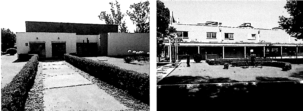
Imagen 2 (conjunto). Construcciones en el predio conforme a las especificaciones del Uso de Suelo.
