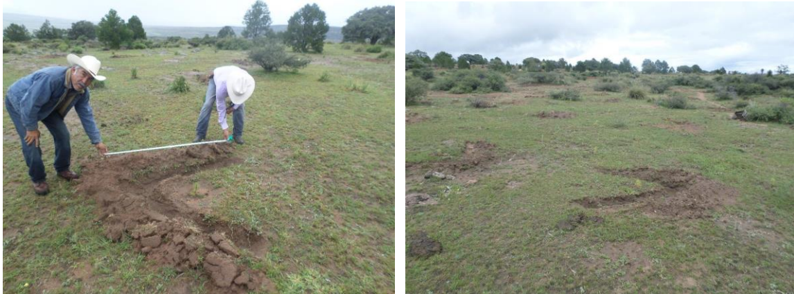
Imagen 23 y 24. Colectores en "V" con diferentes longitudes de bordo
