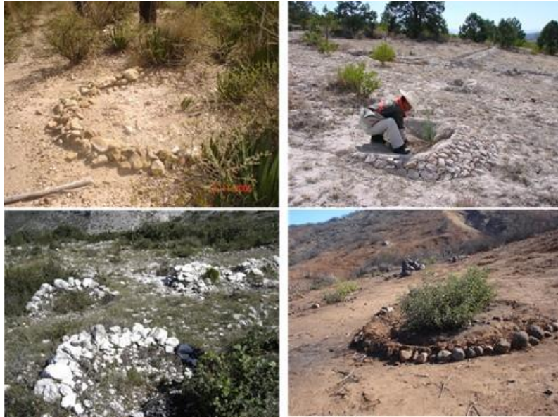
Imagen 39, 40, 41 y 42. Reforzamientos de bordos con piedras
