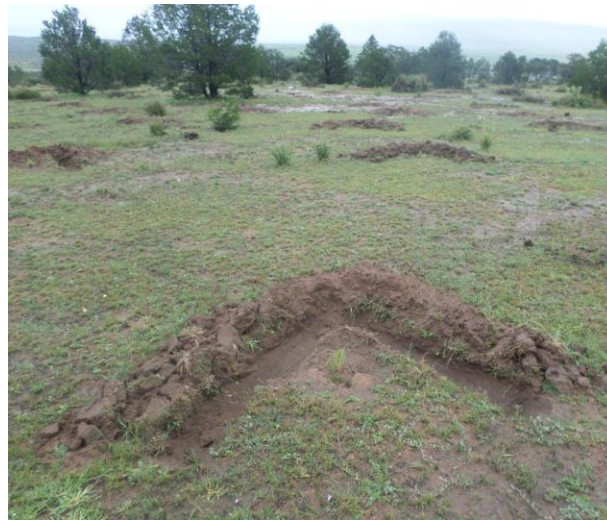
Imagen 22. Vista de colectores en “V”
