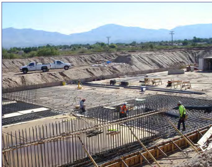
Construcción de la nueva planta de tratamiento de Sunland Park.
