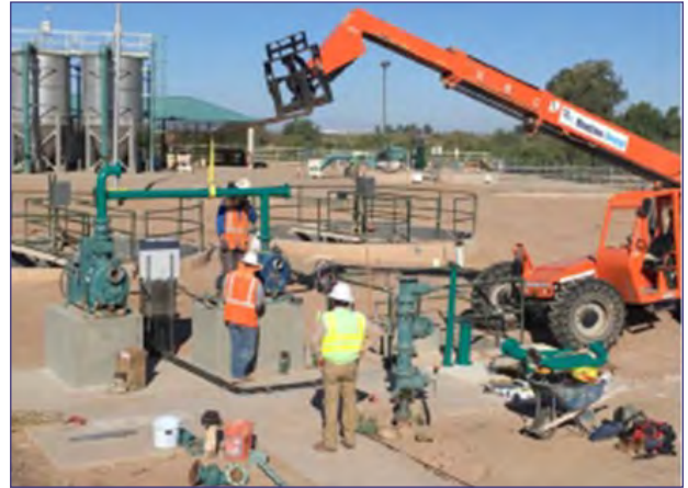
Construcción de una estación de bombeo de aguas pluviales.
