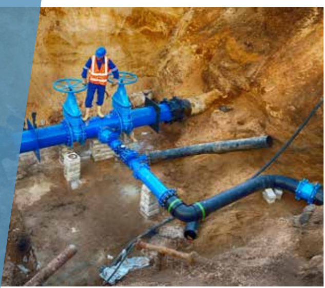
Tuberías bajo tierra
